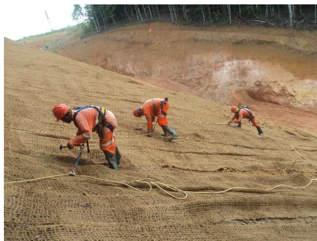
Figura 5. Aplicação de biomanta antierosiva em terreno inclinado.
