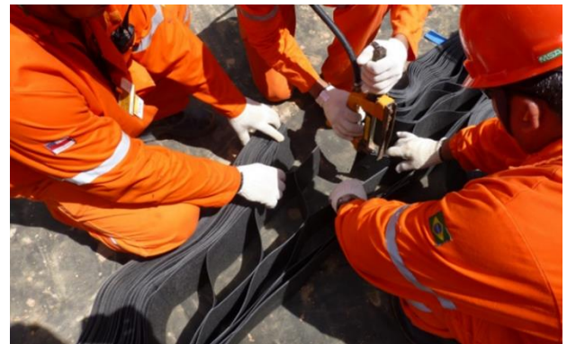
Figura 4. União dos painéis de geocélulas com grampeador pneumático.
