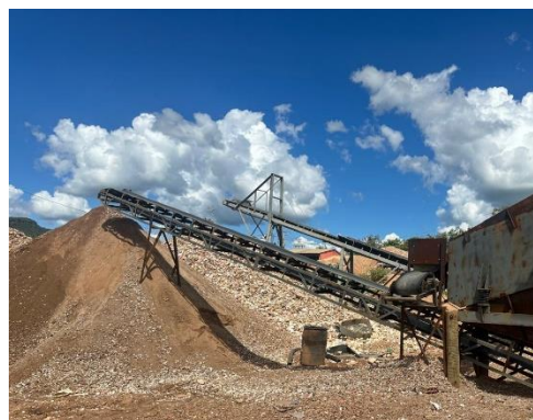
Figura 1. RCC-R produzido na usina de reciclagem.
