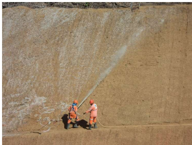
Figura 7. Aplicação de hidrossemeadura Trix Plus® nos taludes.
