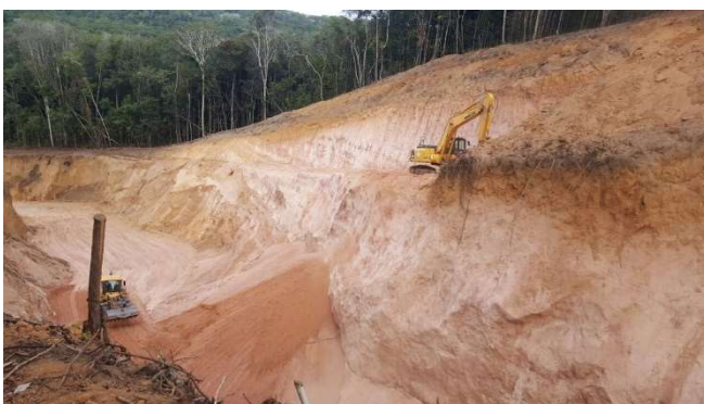
Figura 2. Vista geral da incisão erosiva durante atividades de terraplanagem.
