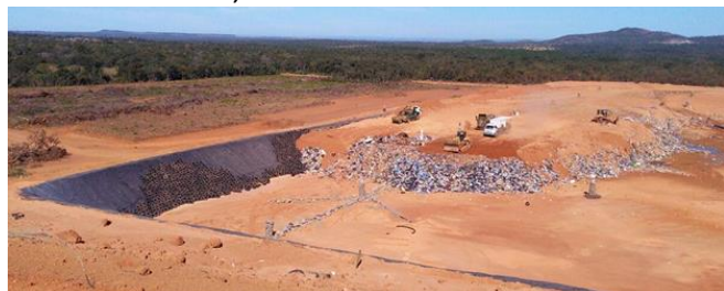
Figura 2. Cobertura diária de resíduos sólidos no aterro sanitário Palmas-TO. (PITANCO; 2019)
