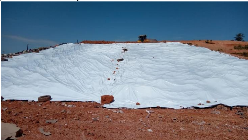
Figura 2. Utilização de filme de PEBDL como cobertura no aterro sanitário de Marituba (cortesia: Letícia Lira).
