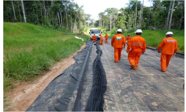
Figura 3. Camada de geotêxtil aplicado como elemento de separação.
