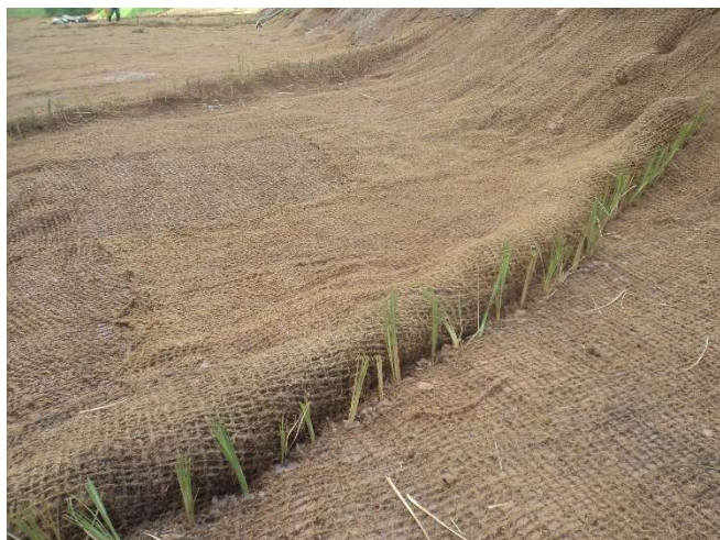
Figura 6. Aplicação de biorretentor Rollitech® e plantio de mudas de capim Vetiver®.
