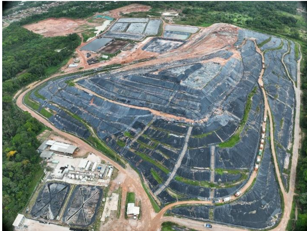
Figura 1. Vista aérea do aterro sanitário de Marituba, podendo-se visualizar que a maior parte do aterro está coberto com geomembranas de PE (cortesia: Guamá Tratamento de Resíduos).
