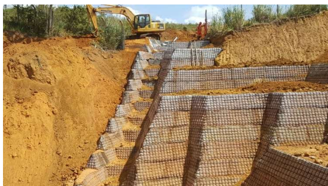
Figura 4. Contenção da cabeceira da incisão erosiva com Sistema Vertical Green Wall®.
