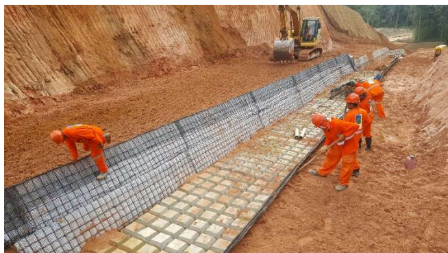
Figura 3. Execução da Ecocalha® em solo reforçado e revestimento com blocos em concreto articulados (Concret Channel®).
