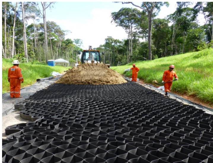
Figura 5. Geocélula aplicada, sendo preenchida com solo arenoso.
